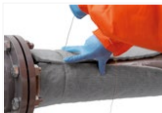
Figure 13: Commencez à rassembler les joints longitudinaux et fixez avec du fil de fer.
