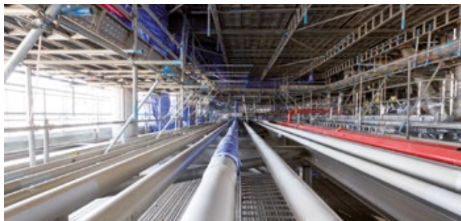
Figure 9: Si des conditions météorologiques défavorables sont prévues, prévoyez de couvrir les zones de travail. Évitez que l'isolation ne soit mouillée.
