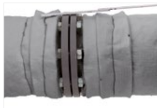
Figure 31: Enveloppez avec des bandes d'ArmaGel HT de 50 mm (2 pouces) de largeur pour installer l'isolation de façon à dégager la bride (ou ajustez la largeur afin qu'elle soit égale à l'épaisseur totale de l'isolation si elle est > 50 mm).
