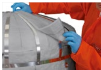
Figure 62: Les joints dans les couches ultérieures doivent être décalés.
