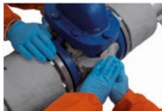
Figure 55: Enveloppez ArmaGel HT autour du corps de la vanne pour empêcher des vides d'air.
