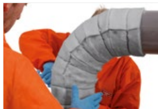
Figure 37: Réunissez tous les poissons en les rassemblant afin de veiller à ce qu'il n'y ait pas de jeux et resserrez les fils de fer.
