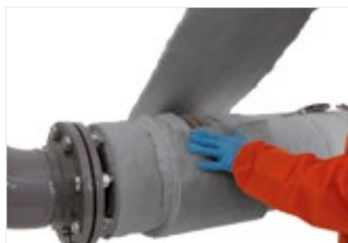
Figure 32: Entourez avec la même épaisseur que celle de l'ArmaGel HT sur le tuyau.
