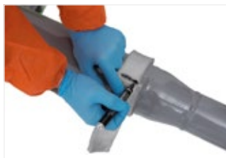
Figure 42: Mesurez les deux circonférences au niveau des soudures.
