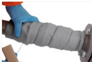
Figure 29: Entourez en spirale avec du fil de fer pour maintenir l'ArmaGel HT en place.
