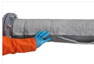
Figure 14: Continuez à effectuer le raccord, en fermant les jeux.
