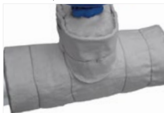
Figure 59: Mettez le fil de fer pour le maintien en place.
