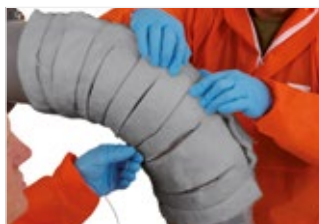
Figure 40: Réunissez tous les fuseaux en les rassemblant afin de veiller à ce qu'il n'y ait pas de jeux ou de vides.
