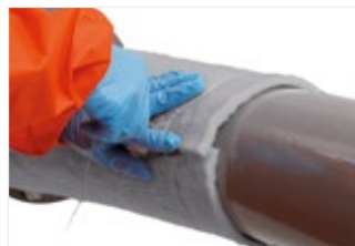
Figure 12: Raccord longitudinal avec chevauchement.
