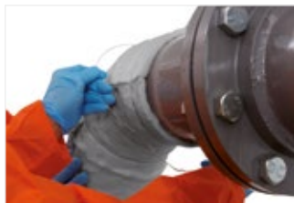
Figure 35: Assurez-vous que tous les joints sont étanches sans jeux et qu'ils sont bien ajustés au tuyau, sans laisser de jeux.
