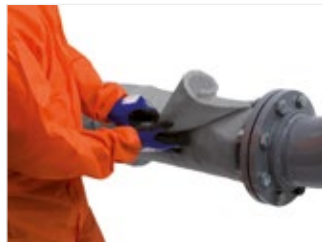
Figure 25: Continuez à envelopper le tuyau pour obtenir la quantité de couches requise. Terminez l'enveloppement avec le bord longitudinal situé dans le prolongement du point de départ de la couche intérieure, ou chevauché par celui-ci.
