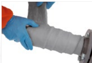
Figure 28: Entourez le tuyau de bandes d'ArmaGel HT larges de 50 ou 100 mm. Le matériau peut être soit posé de manière serrée ou chevauché à 50 %.
