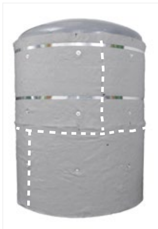
Figure 60: Isolez à partir de la ligne de soudure du couvercle du réservoir. Maintenez la feuille d'ArmaGel HT avec des clips de fixation d'isolation, en échelonnant tous les joints, ensuite ancrez chaque couche au feillard autour du récipient.
