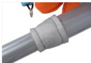
Figure 44: Adaptez autour de la réduction et entourez d'un fil de fer pour le maintenir en place.
