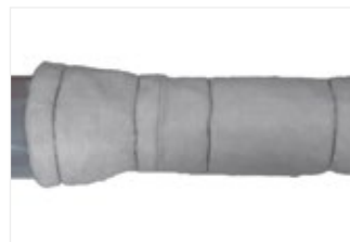
Figure 45: Comprimez fermement l'isolation du tuyau sur la réduction.
