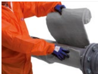
Figure 24: : Veillez à ce que le point de départ se situe dans le prolongement de l'axe du tuyau. De la colle ou de l'adhésif peut s'avérer nécessaire pour aider au maintien de la position axiale.
