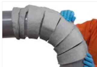
Figure 39: Positionnez les découpes sur la gorge intérieure du coude, avec le joint longitudinal sur l'extérieur du coude.
