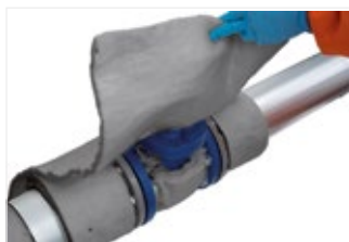
Figure 56: Enveloppez les brides d'ArmaGel HT.
